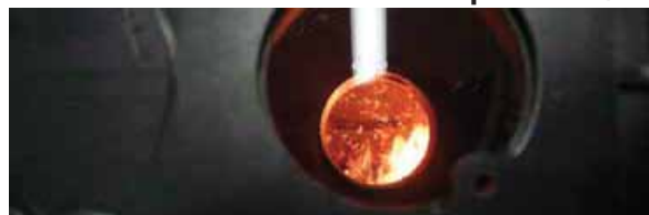
Vizor de observație către camera de ardere
